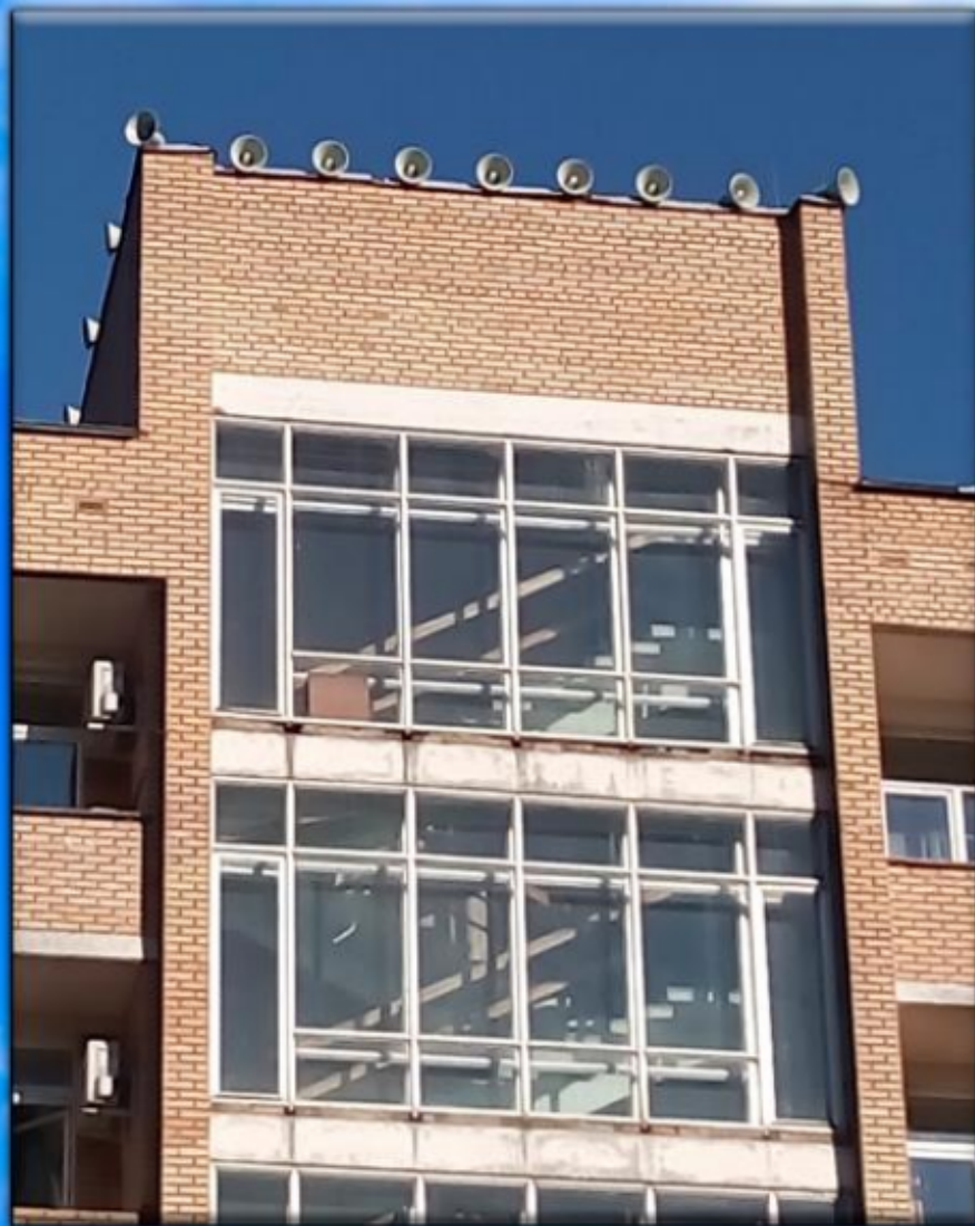
Монтаж к стене здания
